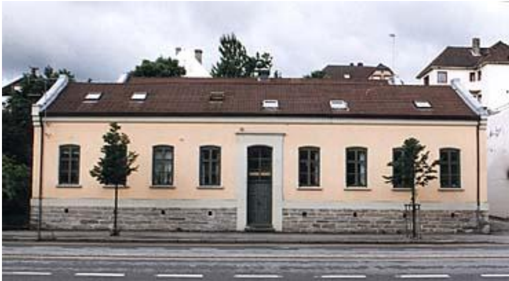
Det gamle fengselet på Lagårdsveien fra 1862.
